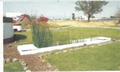
Biofiltro y humedal para tratamiento de agua residual.
